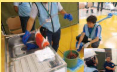
課題1の室内枝管高圧洗浄
