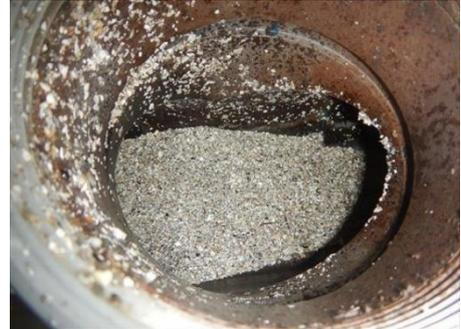
写真1 排水横主管の堆積状況
