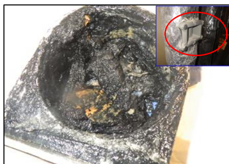
写真4 立て管掃除口の状況
