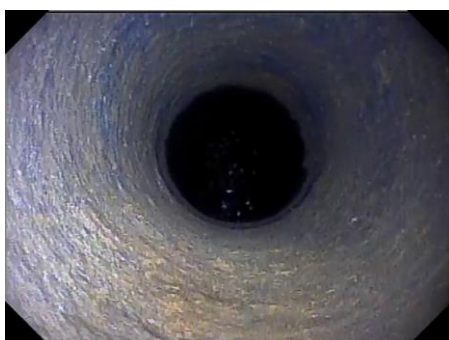
写真2 排水用鋳鉄立て管（清掃後）
