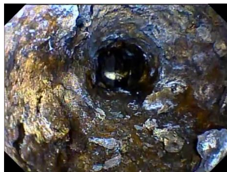
写真1 排水用鋳鉄立て管（清掃前）
