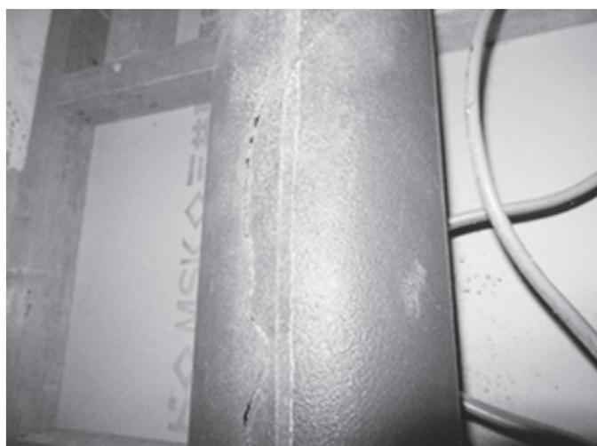
写真1 立て管縦割れ状況
