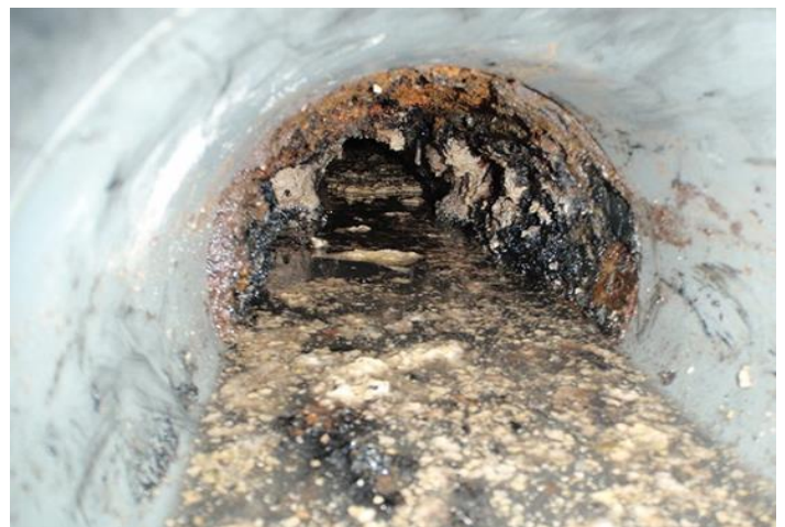
写真 7 清掃中に停滞した粉砕物・油脂固形物
